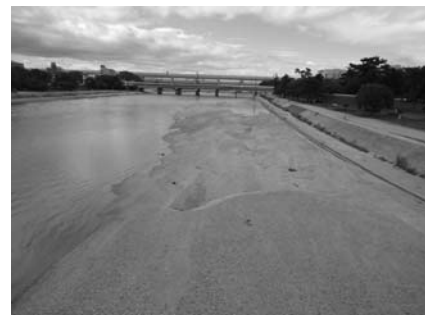
写真5 台風に伴う堰自然転倒時に現れた砂州
