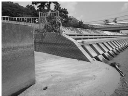
写真6 潮止め堰全転倒時の魚道付近穴あきブロック
