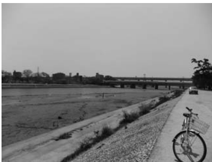
写真2 潮止め堰転倒時の武庫川橋下流部堆積ヘドロ
