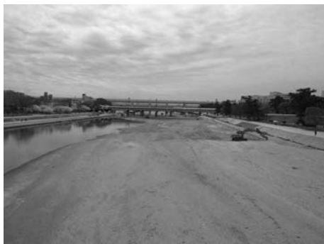
写真3 潮止め堰転倒時に生じた砂州
