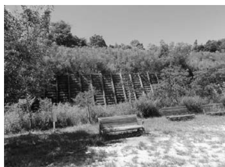
写真5 水抜きがされている地すべり現場
