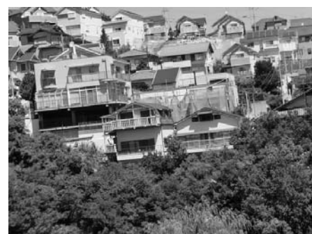
写真6 急斜面に建ち並ぶ住宅群（仁川町六）
