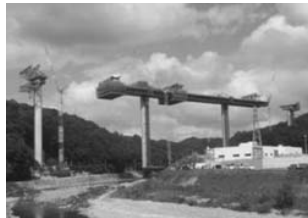
写真17 武庫川橋工事
