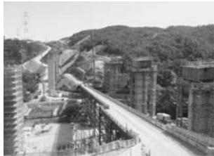
写真16 道場トンネル工事
