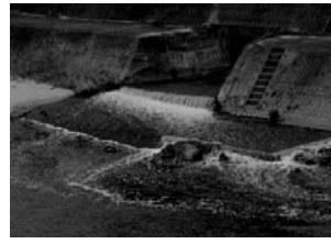
写真8 上流浄化センター排水口
