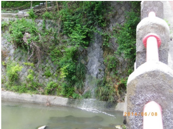
写真 11 温泉橋上流側排水
