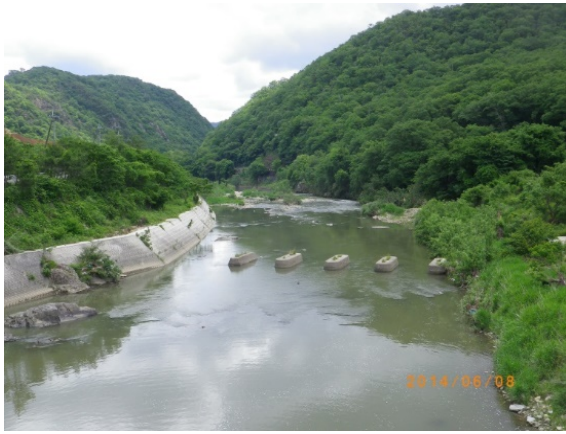
写真 9 大岩橋下流左岸
