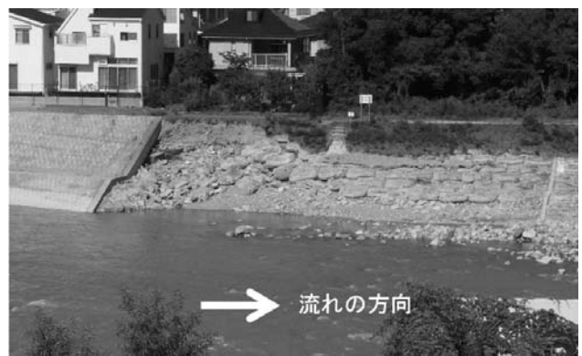
図3 生瀬東町地先の河岸浸食状況 2014年8月洪水後の撮影
