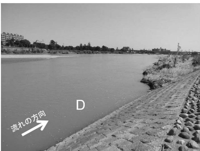
図5 仁川合流点上流右岸沿い寄洲の2014年洪水による発達 左: 2013年9月洪水後の撮影 右: 2014年8月洪水後の撮影 2013年9月の水域D → 2014年8月洪水で発達した寄洲E
