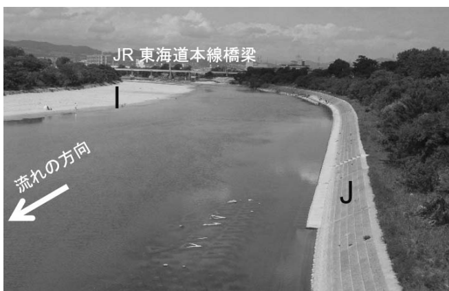
図9 JR東海道本線橋梁下流の強固な護岸設置 (2014年洪水後の撮影, I: 寄洲, J: 根固め付設護岸)
