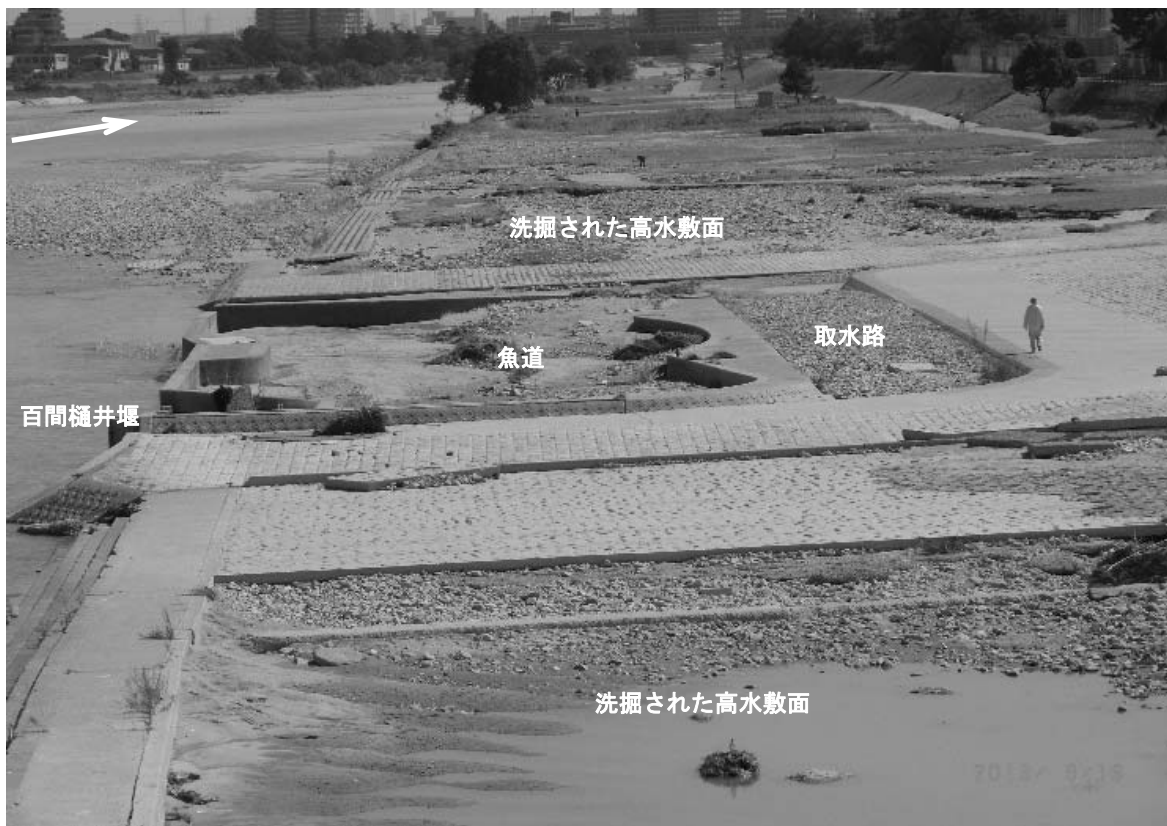
写真 7 砂礫で埋もれた百間樋井堰取水路と魚道 (武庫川新橋下流側右岸高水敷, 2013. 09. 18 撮影)
