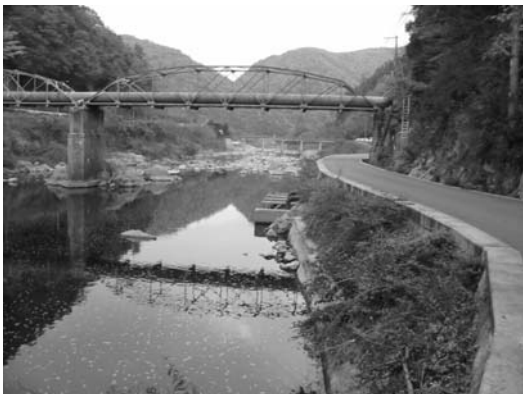
写真3 神戸市水道水管橋
