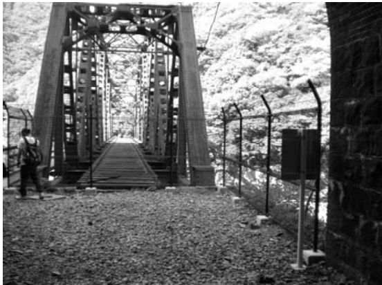
写真 9 旧第二武庫川橋梁
